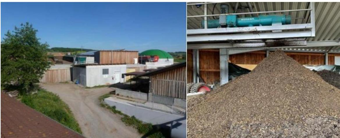
Figura 13. Planta de biogás con sala técnica, silos, tanque de fermentación, depósito y depósito de gas (izquierda) y separador de fracciones sólidas (derecha; E. Räder)
